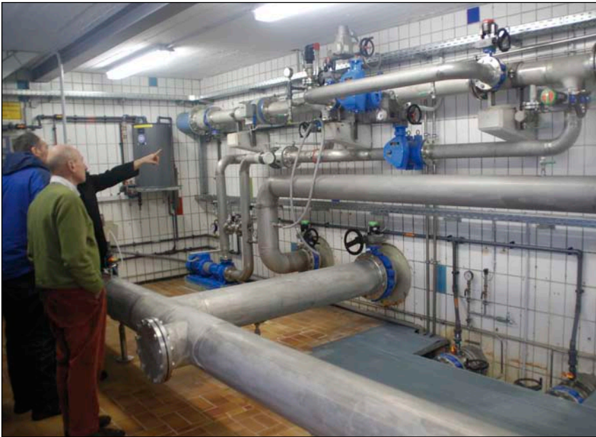
Bild 1: Abzweig zur Turbine
