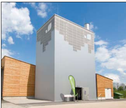
Bild 1: Vergasungskraftwerk mit einem Heatpipe-Reformer im bayerischen Achenal
