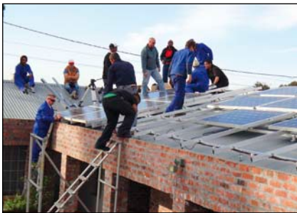
Netzgekoppelte Aufdachanlage in Kapstadt im Bau
