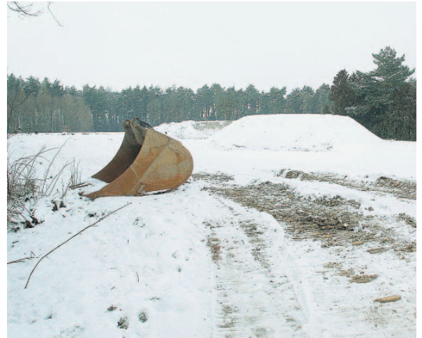
Hier soll ein innovatives Neubaugebiet entstehen. Das Gebäude der Kühedorfer Brennereigenossenschaft ist bereits dem Erdboden gleichgemacht. Foto: Graff
